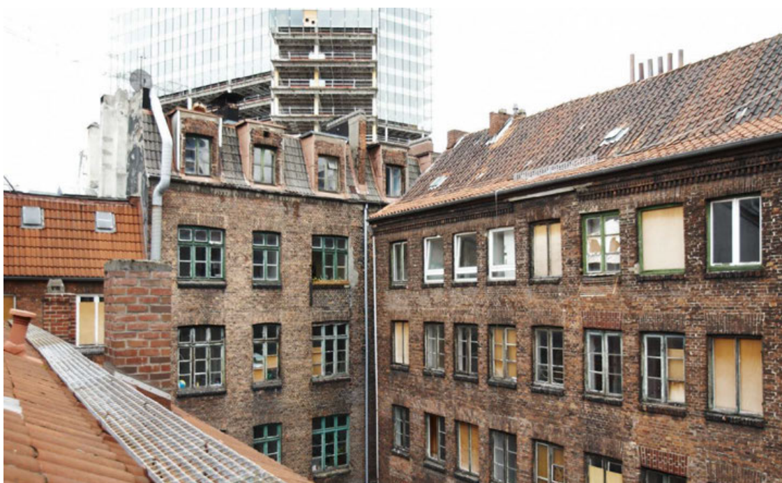
Figure 4: The Gängeviertel buildings (Franziska Holz)
